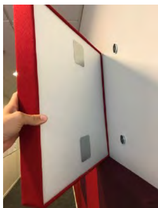
Enkel montering med magneter
